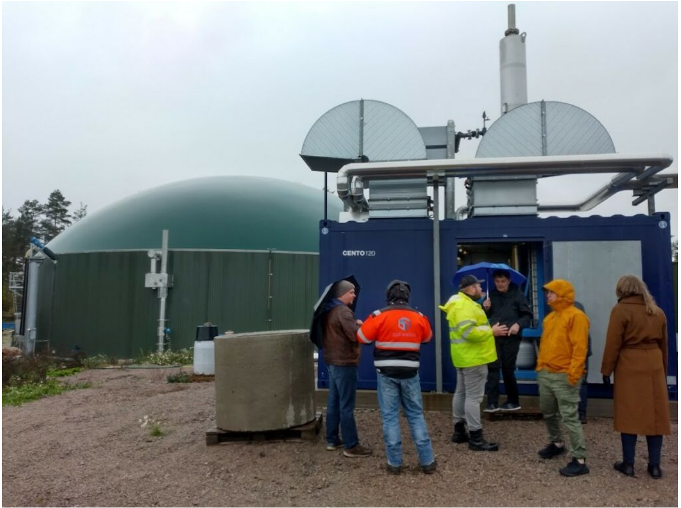
Kuva 4. Biopir Oy:n biokaasukattila (Cento120) ja -reaktori taustalla (Kuva: Kari Laasasenaho).
