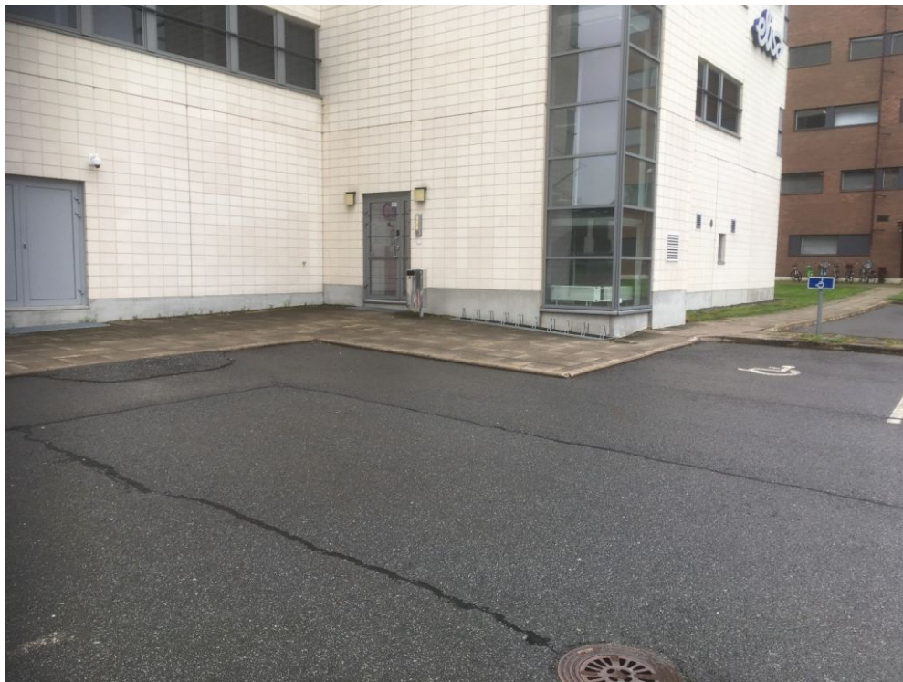
Kuva 2. Esteetön pysäköintipaikka Frami C:n päädyssä.
