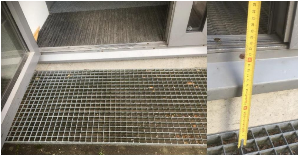
Kuva 6. Sisäänkäynti Frami C:hen.
