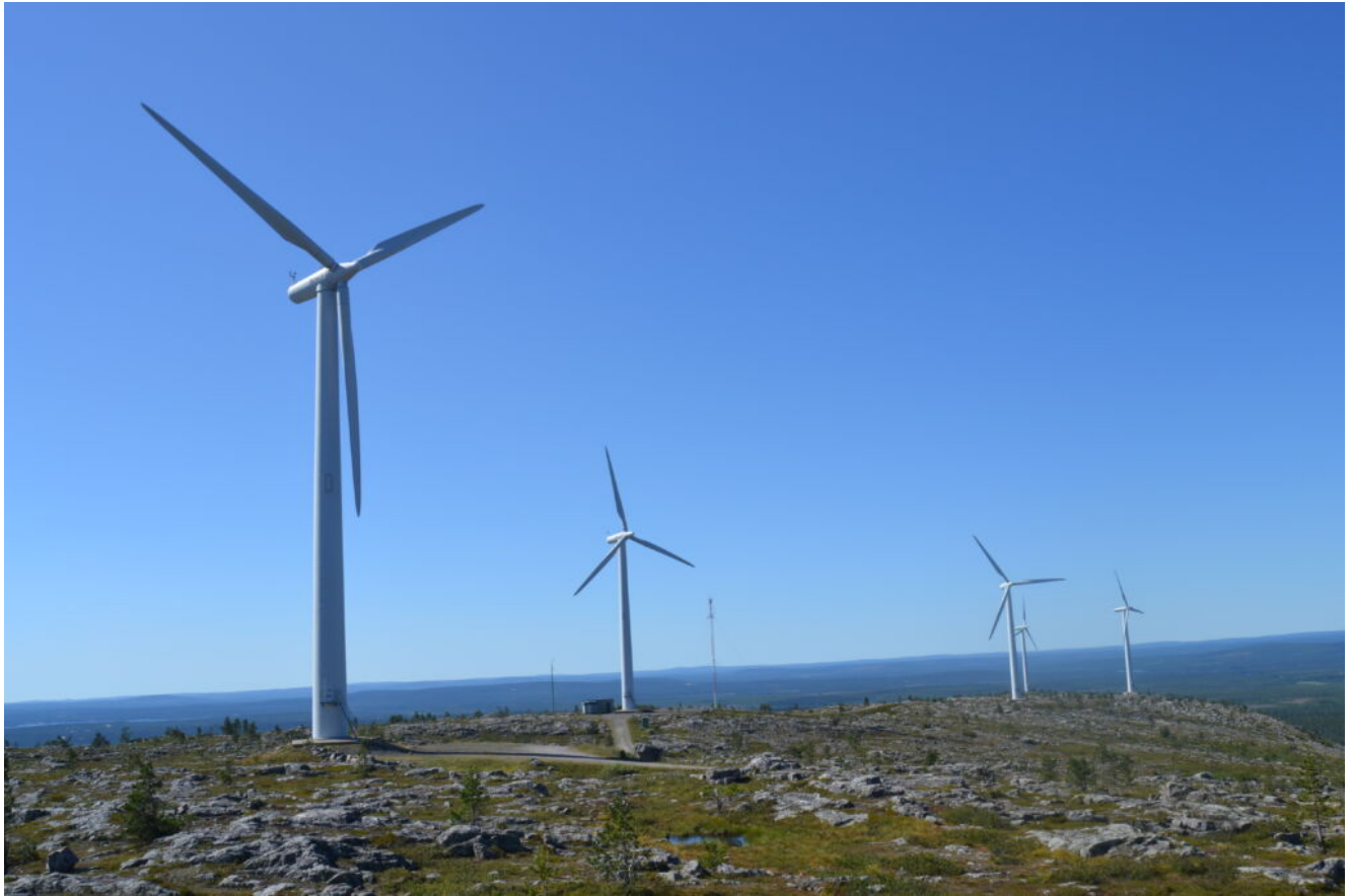
Kuva 1. Olostunturin laella sijaitsevat viisi Siemens Gamesan valmistamaa 0,6 MW tuulivoimalaa. Voimaloiden napakorkeus on 41 metriä (kuva: Antti Leppänen).
