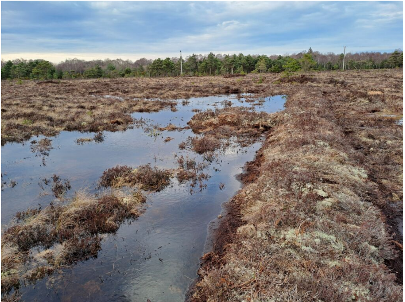
Kuva 2. Patovallilla ennallistettu kohosuo Irlannissa. Patovalli on tehty pintaturpeesta kaivinkoneella (kuva: Kari Laasasenaho, 2025).
