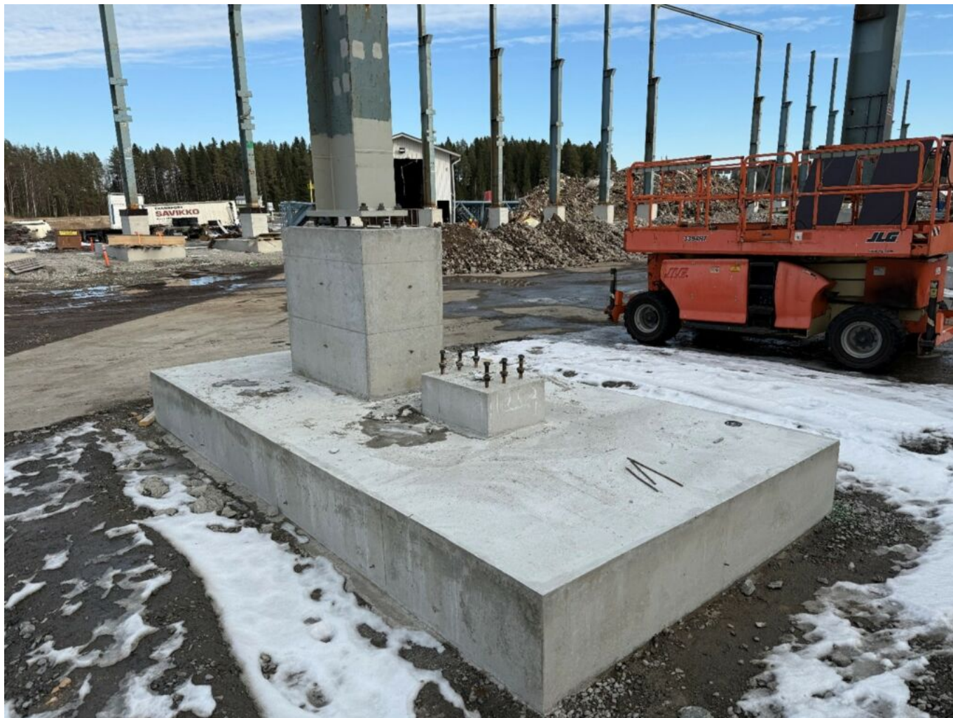
Paikallavalettu pilaririantura ja korotuspilari. Alempi pulttikori odottaa lisäteräspilaria, jolla toteutettiin hallin lisäjäykistys, koska pilareita jatkettiin (kuva: Jorma Tuomisto).
