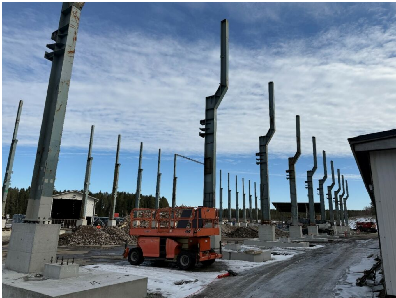
JL-Metals'in uudelleenkäyttöön koottavan teräshallin runko työn alla (kuva: Jorma Tuomisto).
