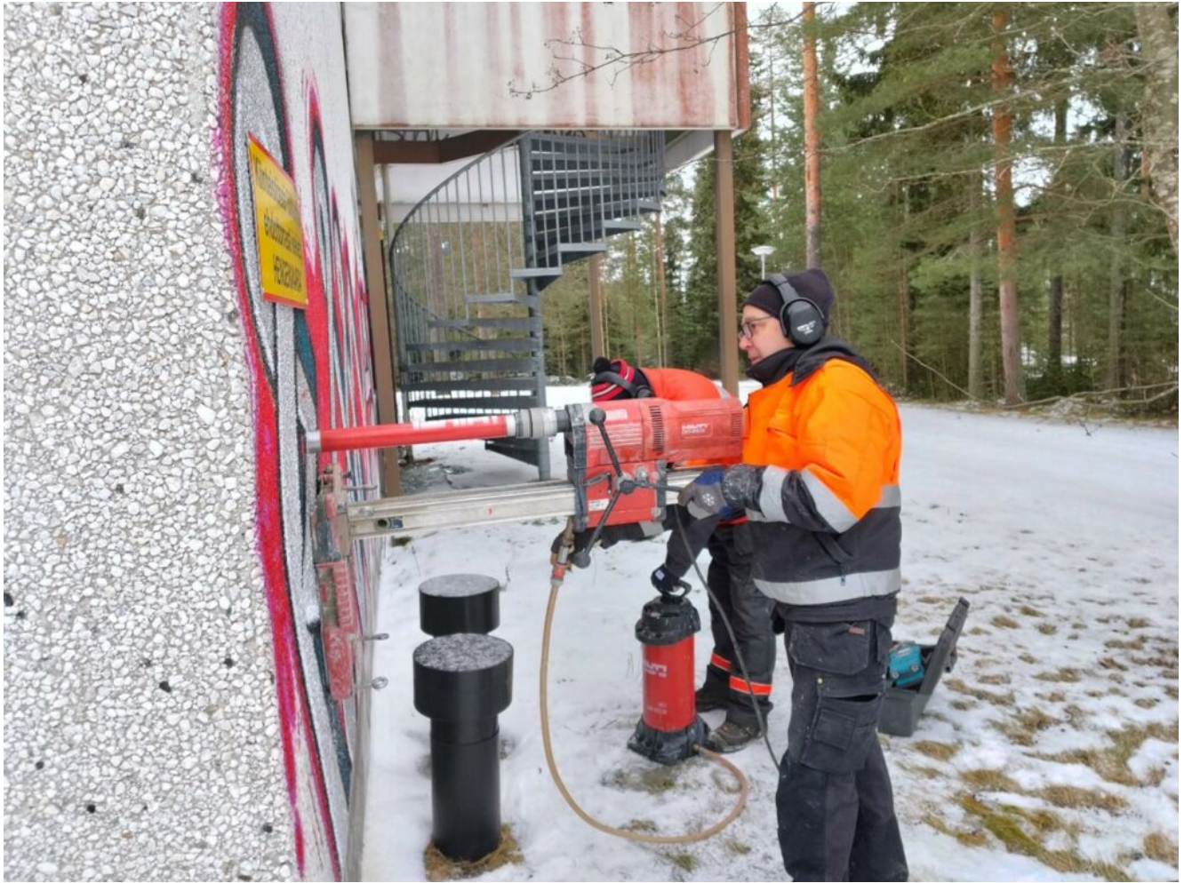
Kuva 1. Seinäjoen vanhan terveydenhuolto-oppilaitoksen betonielementin näytteenotto käynnissä (kuva: Sami Perälä, 2025).
